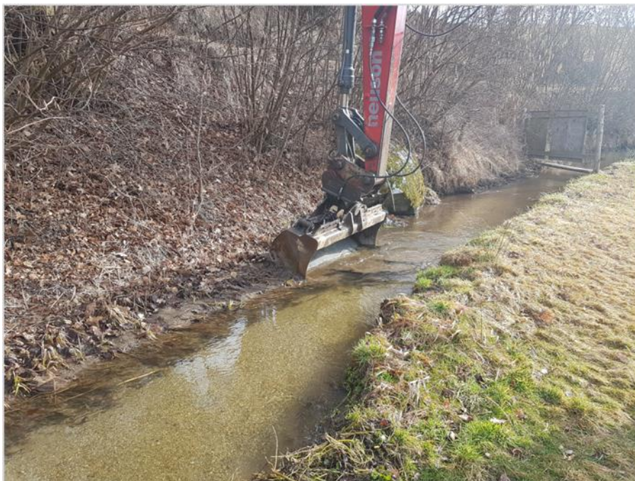
Abb. 22 Entfernung der Makrophyten mittels umgedrehter Baggerschaufel.
