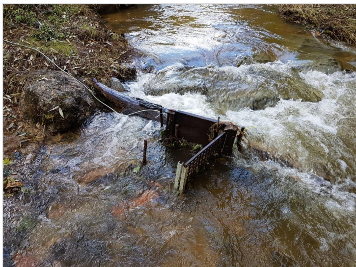
Abb. 4 Das zerstörte Einlaufbauwerk unmittelbar nach dem Hochwasser.
