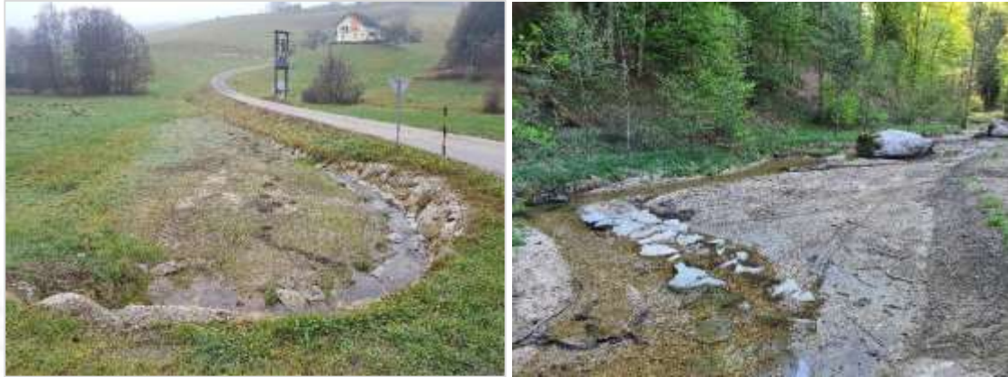
Abb.: Fertigstellung und Inbetriebnahme von zwei Sedimentationsflächen entlang des Käfermühlbaches Ende 2019.
